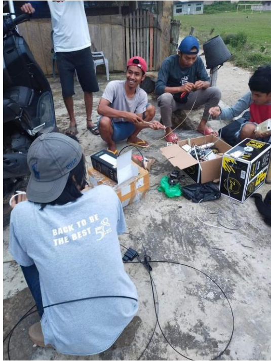
Gambar 9 Pembuatan kabel Fiber Optic
