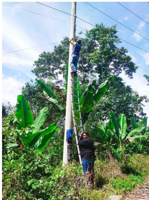
Gambar 10 Penarikan Kabel Fiber Optic
