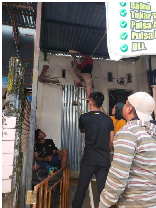
Gambar 8 Pemasangan di rumah Client
