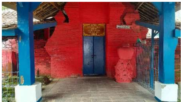
Gambar84. Pintu utama menuju bangunan inti
