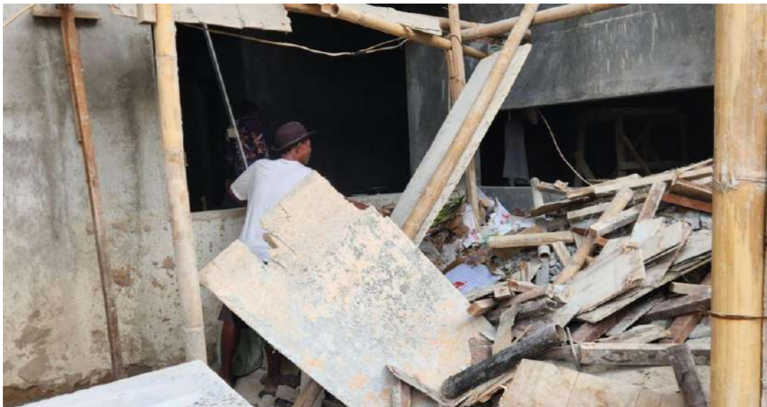
Gambar 8. 4 Pak Dullah Mengambil Barang Bekas di Rumah yang Sedang Dibangun
